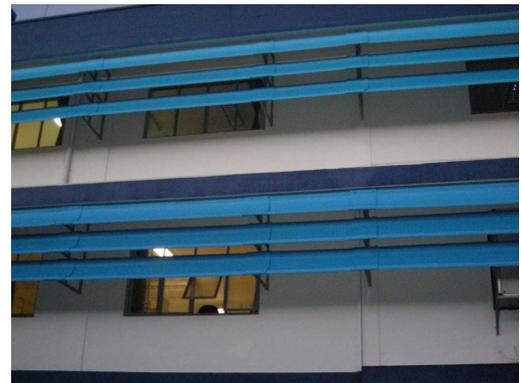
Figura 4.6 - Proteções solares instaladas nas janelas da edificação
